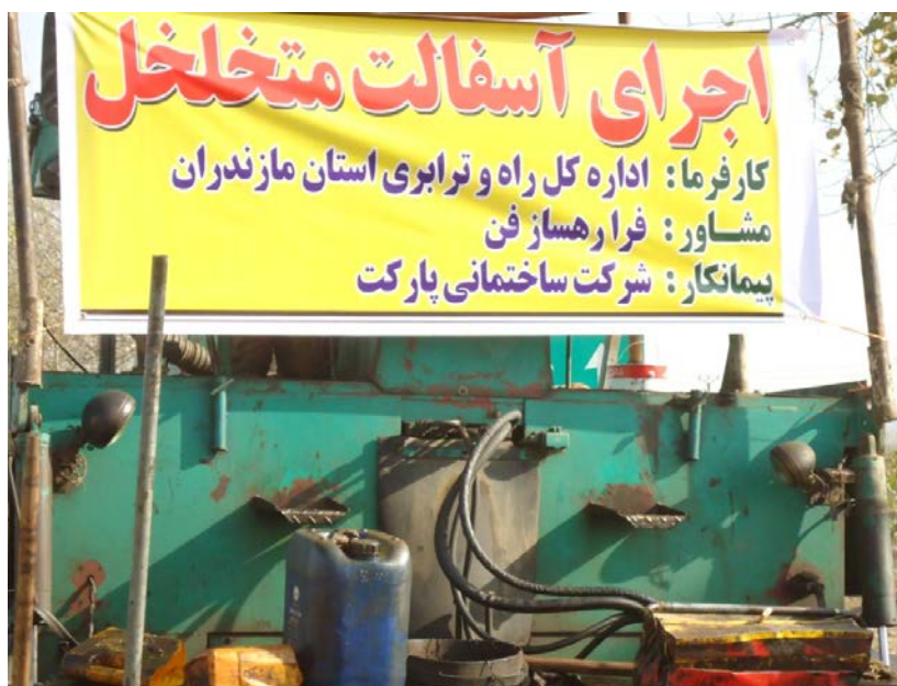
شکل 9-31 اجرای آسفالت متخلخل
