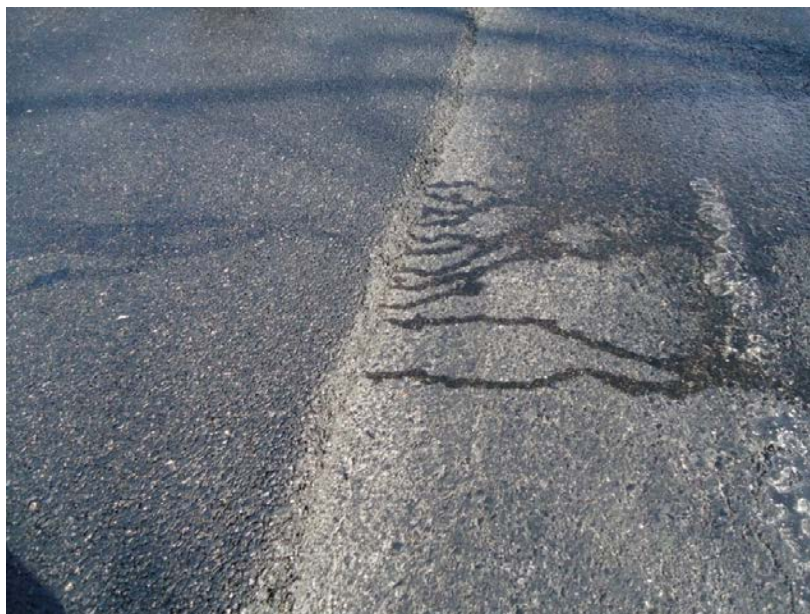
شکل 9-41 زهکش شدن آب از درون آسفالت متخلخل و جاری شدن آن بر روی لایه بیندر
