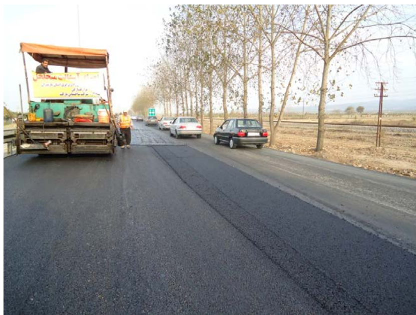
شکل 9-34 اجرای آسفالت متخلخل
