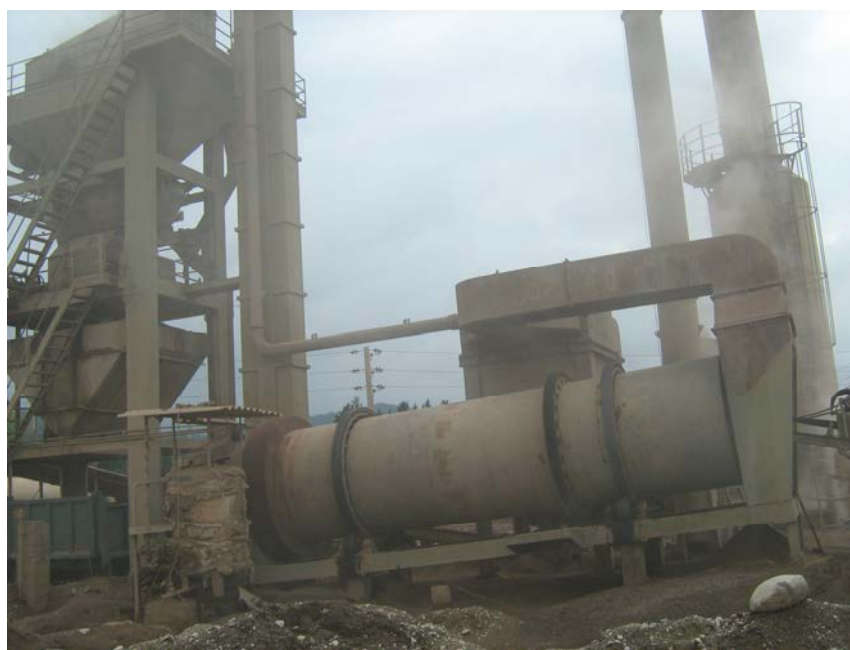
شکل 9-4- کارخانه آسفالت محور کمربندی نوشهر
