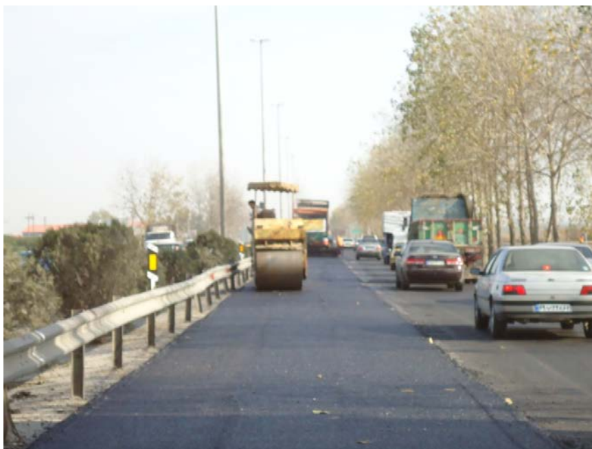
شکل 9-35 استفاده از از غلتکهای چرخ فلزی استاتیکی برای تراکم مخلوط آسفالت متخلخل
