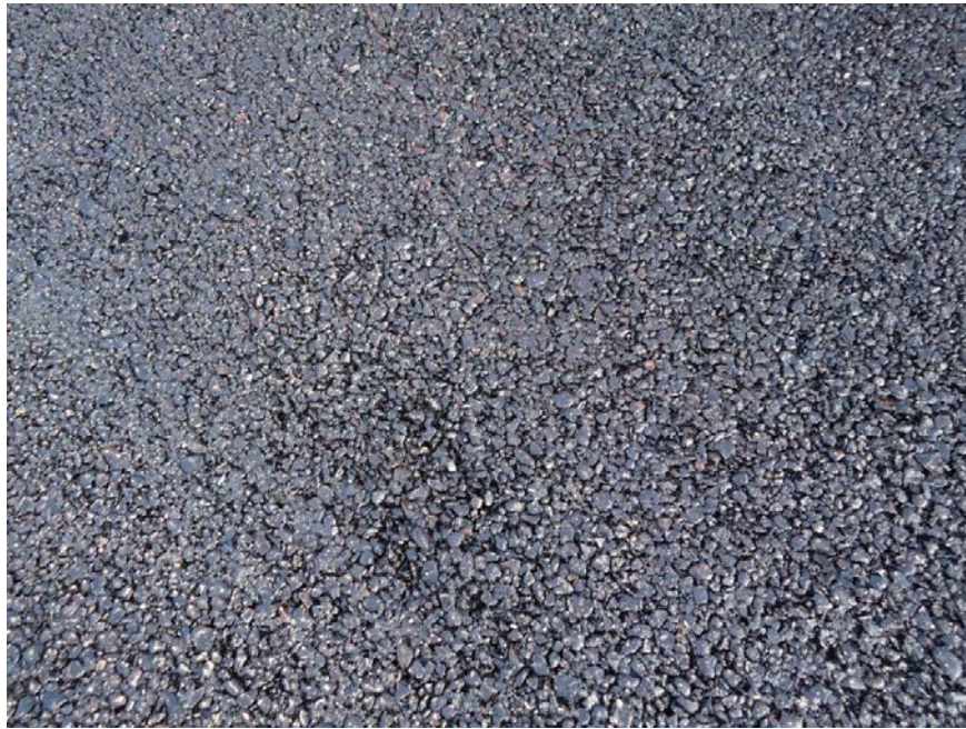
شکل 9-39 سطح آسفالت متخلخل پس از اجرا
