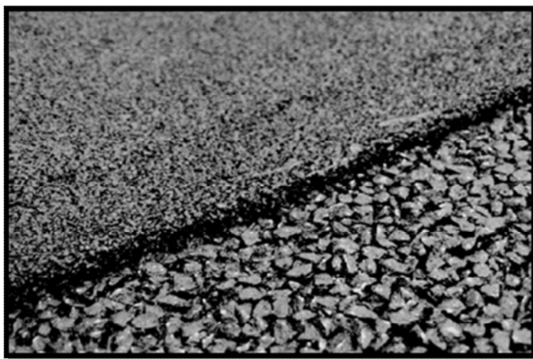
شکل 8-3- آسفالت متخلخل دو لایه‌ای
