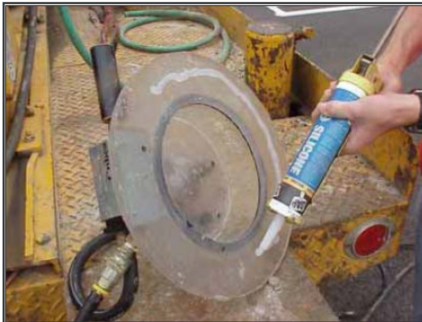
شکل 3-7- نحوه اجرای اتصال سیلیکونی [5]
