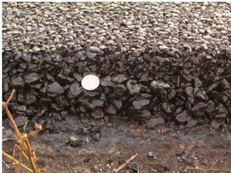
شکل 2-8- آسفالت متخلخل دو لایه در هلند با اندازه مصالح سنگی 6 تا 8 میلیمتر در لایه بالایی
